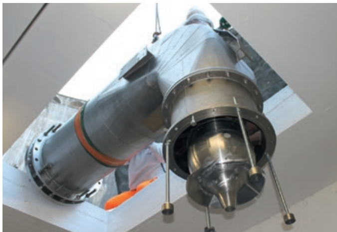
Turbine en montage sur site
